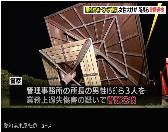
公園の屋根付きベンチ倒壊
